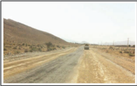
«هشت کیلومتر زایل زینل آباد بهسازی می‌شود»
