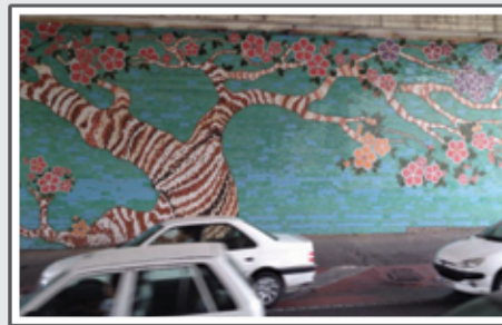
همکاری برای ساخت موزاییک کاری پل تقاطع مدرس و تخت طاووس در تهران
