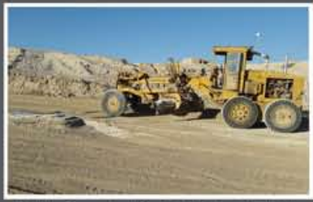
عملیات آسفالت محوطه گلزار شهدای فدای به زودی - عکس: فدای نیوز
