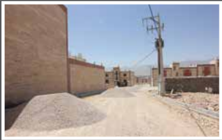
«» خیابان‌کشی در فلان دوم مسکن مهر (پروژه‌های زیئون و کوثر)
